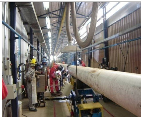
FOTO 5.2.1.1-2: Processo de Solda Elétrica em Tubos
